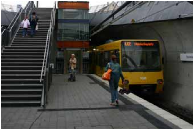
Abbildung 8: Die Stadtbahn in Stuttgart: Fahrzeuge mit den Dimensionen einer U-Bahn mit eisenbahnartiger Infrastruktur, hier in der halb unterirdischen Station Steinhaldenfeld. Die Stadtbahn verkehrt hier unter dem öffentlichen Stadtraum (08/2005)
