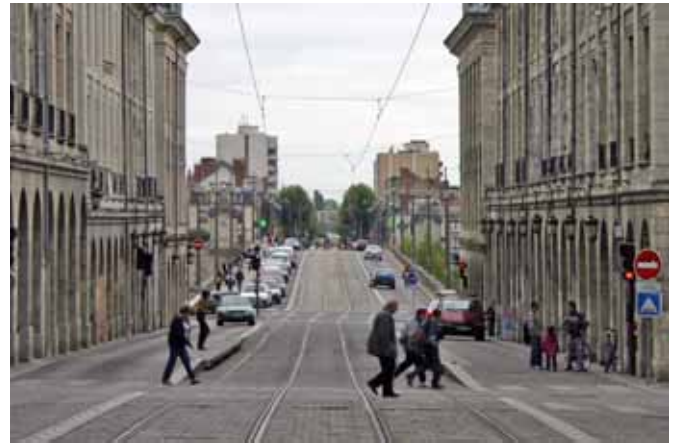
Abbildung 43: Beispiel für sich einfügende Elemente der Stadtbahn-Infrastruktur in sensiblen Stadtbereichen: Rue Royale mit Haltestelle Royale-Châtelet in Orléans (09/2004)
