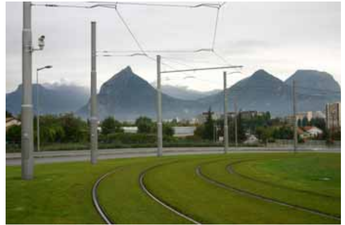
Abbildung 41: Durch die Verwendung von Rasengleisen wird die Stadtbahntrasse zu einem grünen Element der Stadt. Hier im Westen von Grenoble (09/2007)
