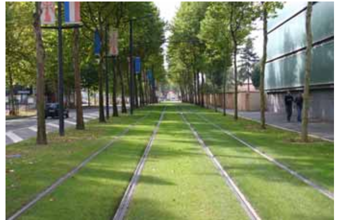
Abbildung 38: Ein weiterer Straßenraum in Mulhouse: Rasengleis in einer Allee in Seitenlage neben der Fahrbahn (10/2007)
