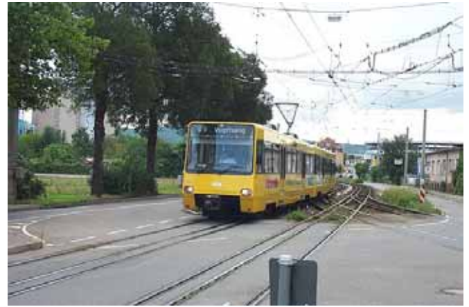
Abbildung 36: Ein typischer Straßenraum mit Stadtbahn in Stuttgart: Der offene Bahnkörper ist nicht durch ein Geländer abgetrennt, lädt aber trotzdem nicht zum Überqueren ein. Die Hochkettenfahrleitungen sind deutlich sichtbar (Quelle: www.urbanrail.net)
